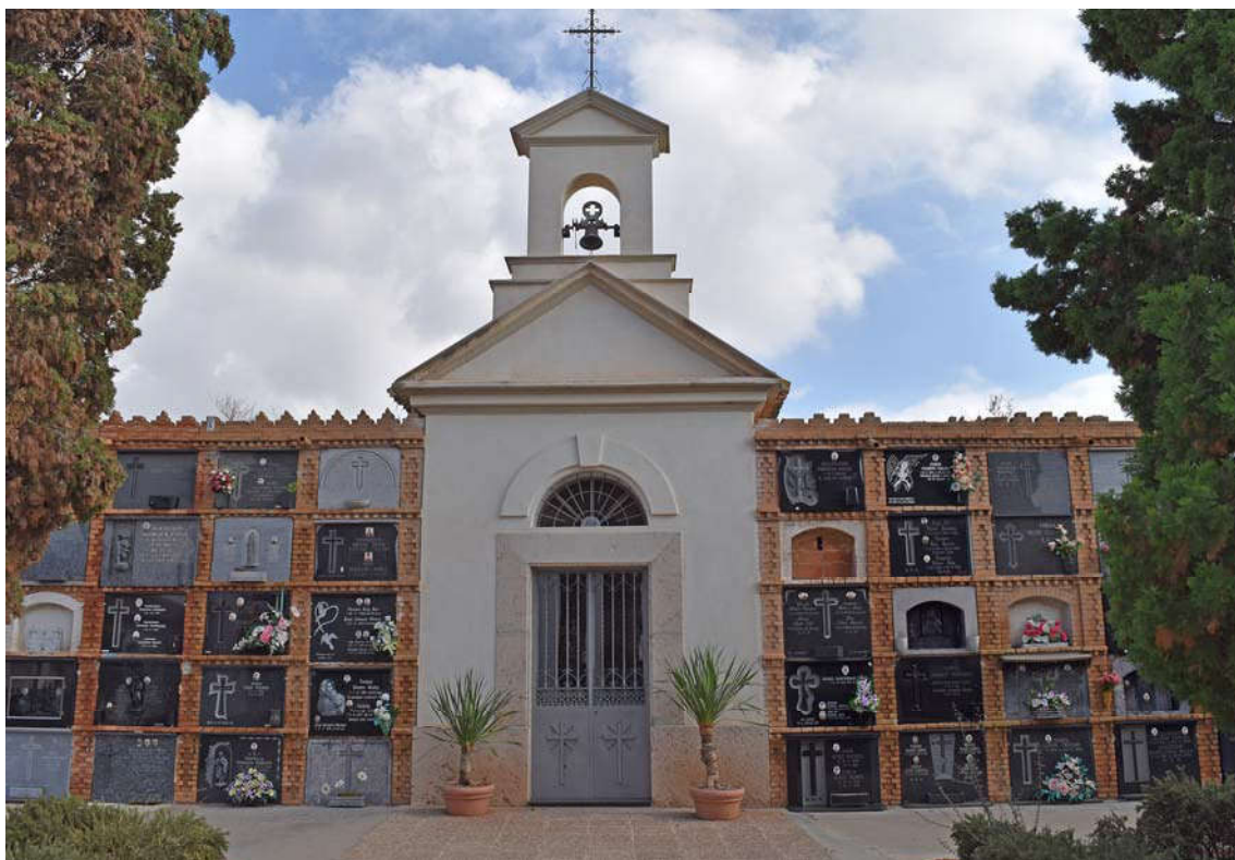
Capilla del Cristo de las Ánimas. Fachada
