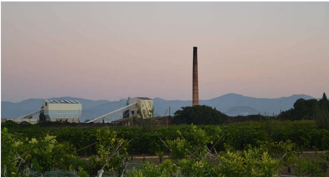
Chimenea de la antigua ladrillera de Bernardo Martínez
