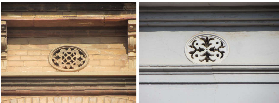
Ejemplos de rejillas de ventilación de cubierta en el núcleo histórico de Albalat dels Sorells
