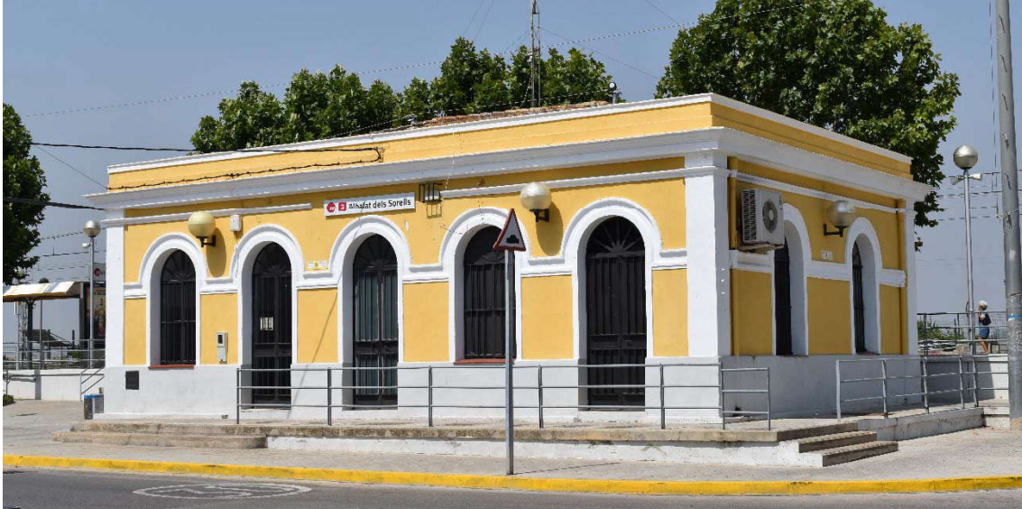
Estación de tren de Albalat dels Sorells
