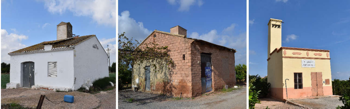
Motores eléctricos en la huerta de Albalat dels Sorells
