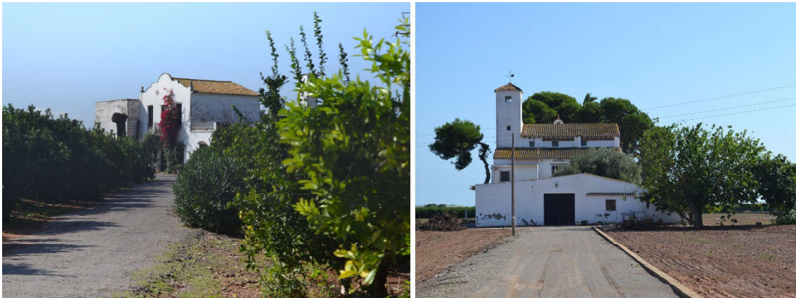
Algunas de las alquerías y mases existentes en el término municipal de Albalat dels Sorells
